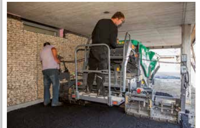
POSE D'ENROBÉ DANS DES HALLES INDUSTRIELLES
