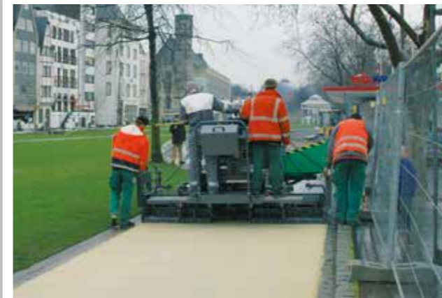
CONSTRUCTION DE CHEMINS EN ESPACES VERTS
