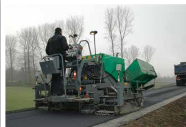
POSE D'ENROBÉ SUR DES DIGUES
