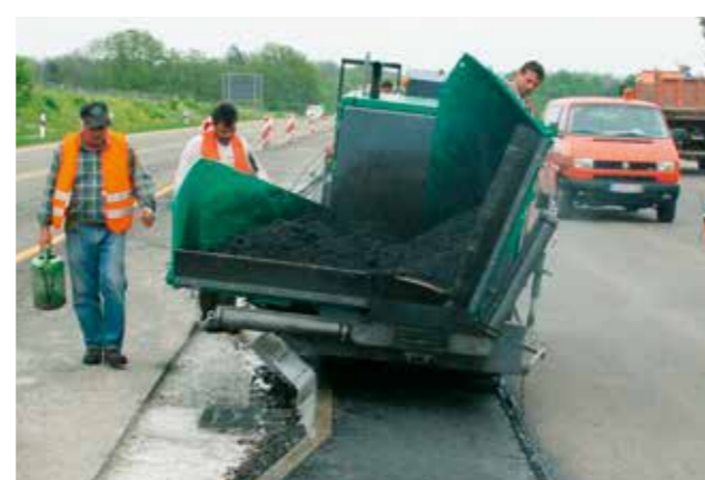
POSE D'ENROBÉ SUR LE TERRE-PLEIN CENTRAL D'AUTOROUTES
