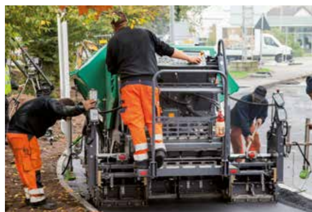
CONSTRUCTION DE CHEMINS RURAUX
