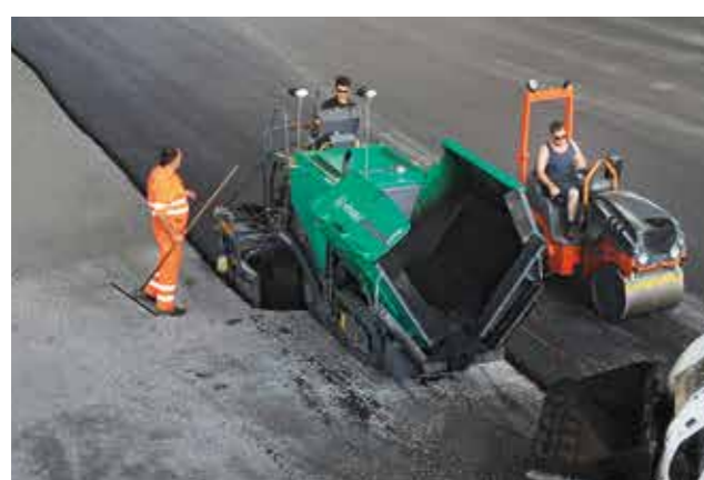
POSE D'ENROBÉ SUR DES TERRAINS DE SPORT
