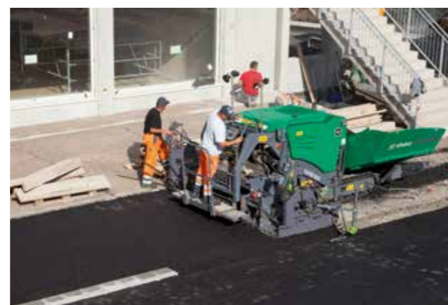
CONSTRUCTION DE PLACES
