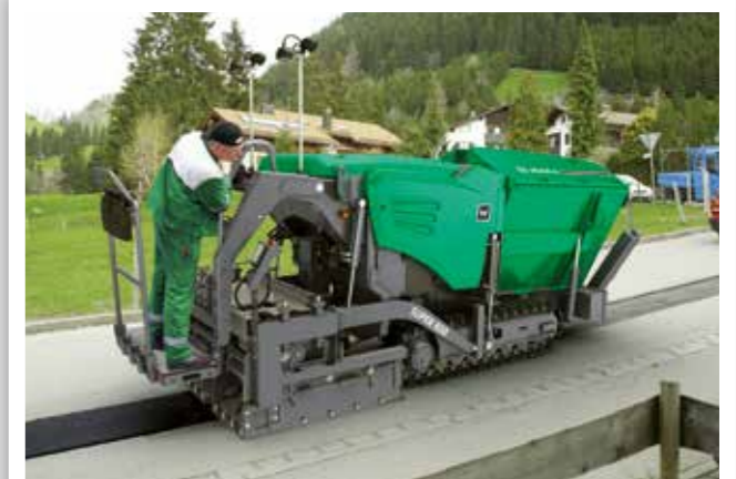
FERMETURE DE TRANCHÉES DE CANALISATION
