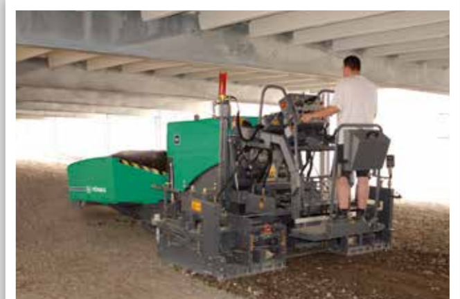
RÉALISATION DE L'ASSISE POUR UNE POSE DE PAVÉS
