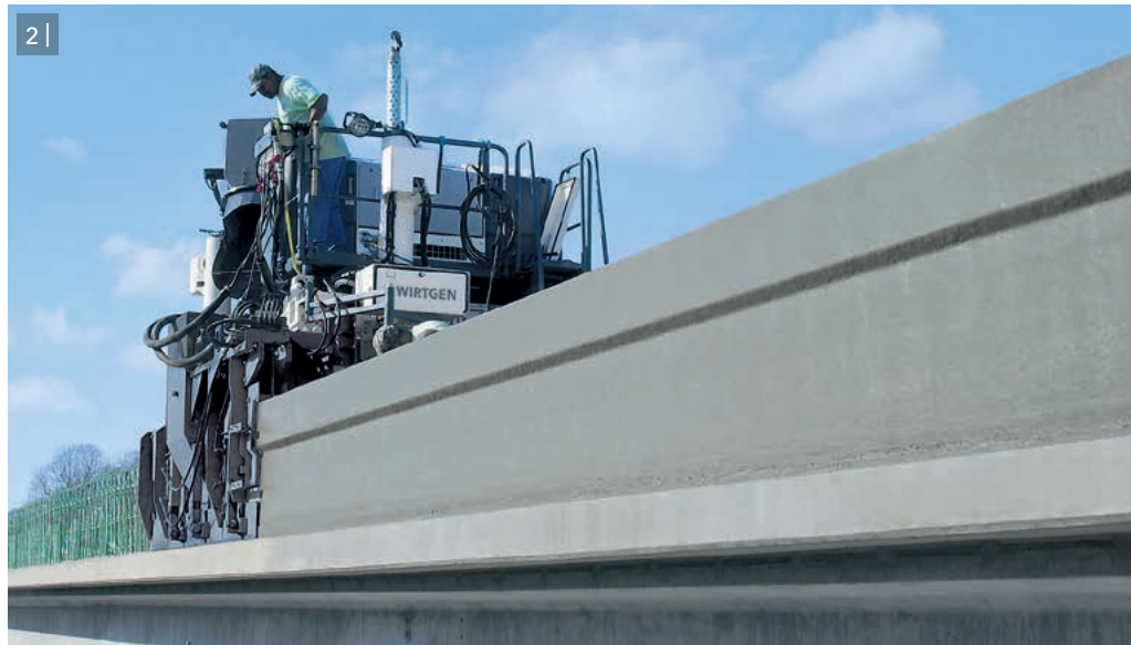
2 | ... qu'à gauche des barrières de protection en béton armé sur toute leur longueur.
